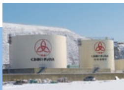
燃油備蓄体制による安定供給
